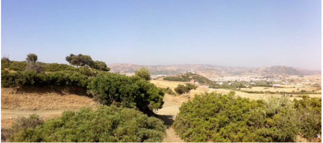
الرقم 9 - 5 خط كهربائي ممر أبراج 68-70
